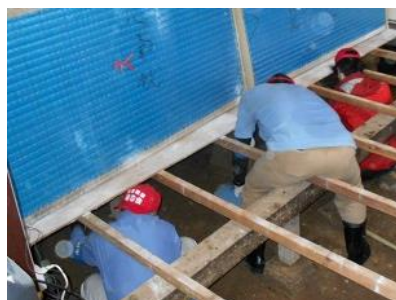
重機が入らない床下は、手作業で泥をかき出す
