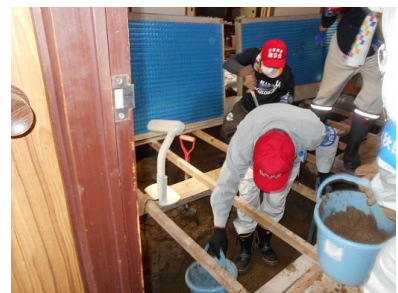
かき出した泥をバケツに入れる
