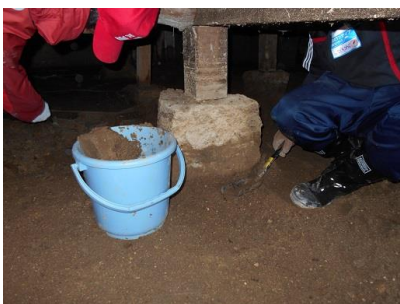
床下の柱には泥の跡がはっきり
