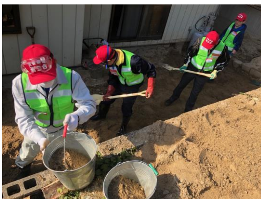
▲霊山地区での土砂撤去作業
